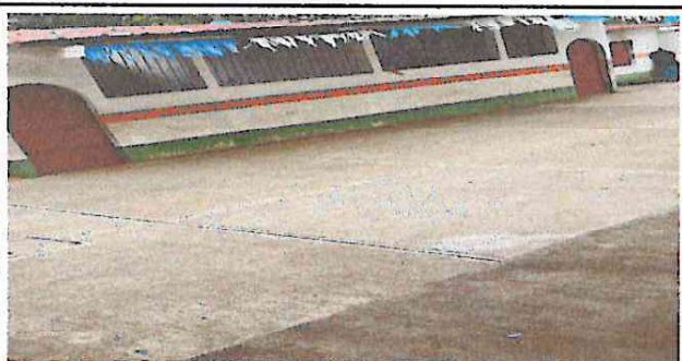
Foto 3: sustitución de canales de metal por estar en mal estado, se quitaron, representaba peligro para los alumnos.
