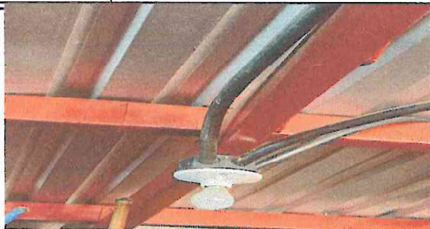
Foto:7 Se sustituirán los focos existentes por mucho consumo de energía, por focos ahorradores.
